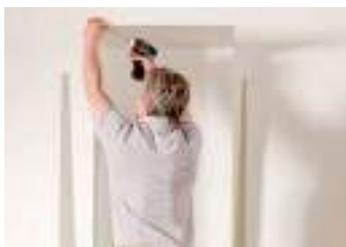
Tenere il cacciavite a batteria pronto e avvitare sull'angolo anteriore. In tal modo è possibile effettuare il montaggio con un unico operatore.
