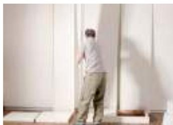
Posizionare il pannello del mobile sulla base. Il posizionamento del particolare risulta molto facile dovuto alle viti sporgenti
